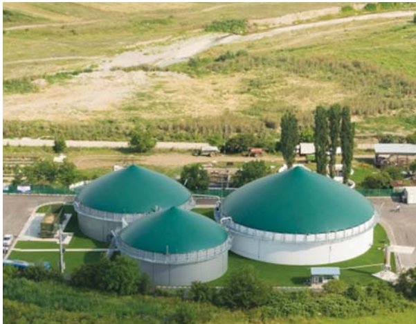
하루 가축분뇨 70톤과 폐수 30톤을 처리하여 유기질 액비와 함께 835 kWh의 전기를 생산하는 전북 김제시 바이오 가스 플랜트(출처: 한국경제)
