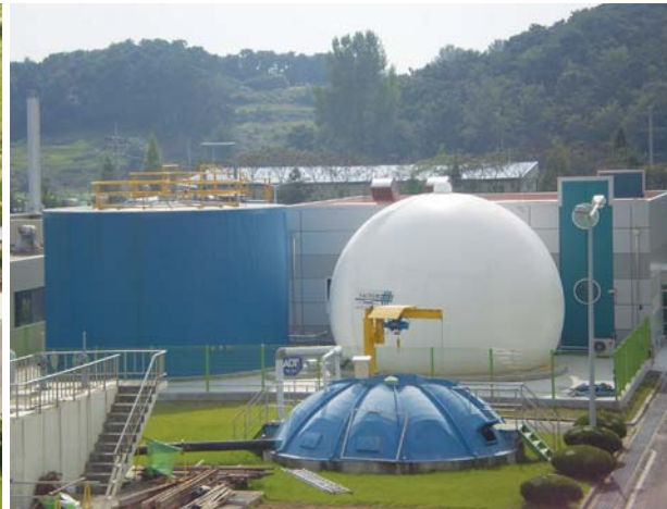
아산하수처리장 바이오 가스 플랜트(100톤/일)는 음식물 처리 폐수 25톤, 축산분뇨 50톤, 하수슬러지 25톤으로 하루에 총 100톤의 유기물을 처리하여 메탄과 이산화탄소의 혼합기체로 천연가스와 유사한 성상을 가진 바이오 가스(메탄가스) 약 1250 m 3 를 생산한다.
